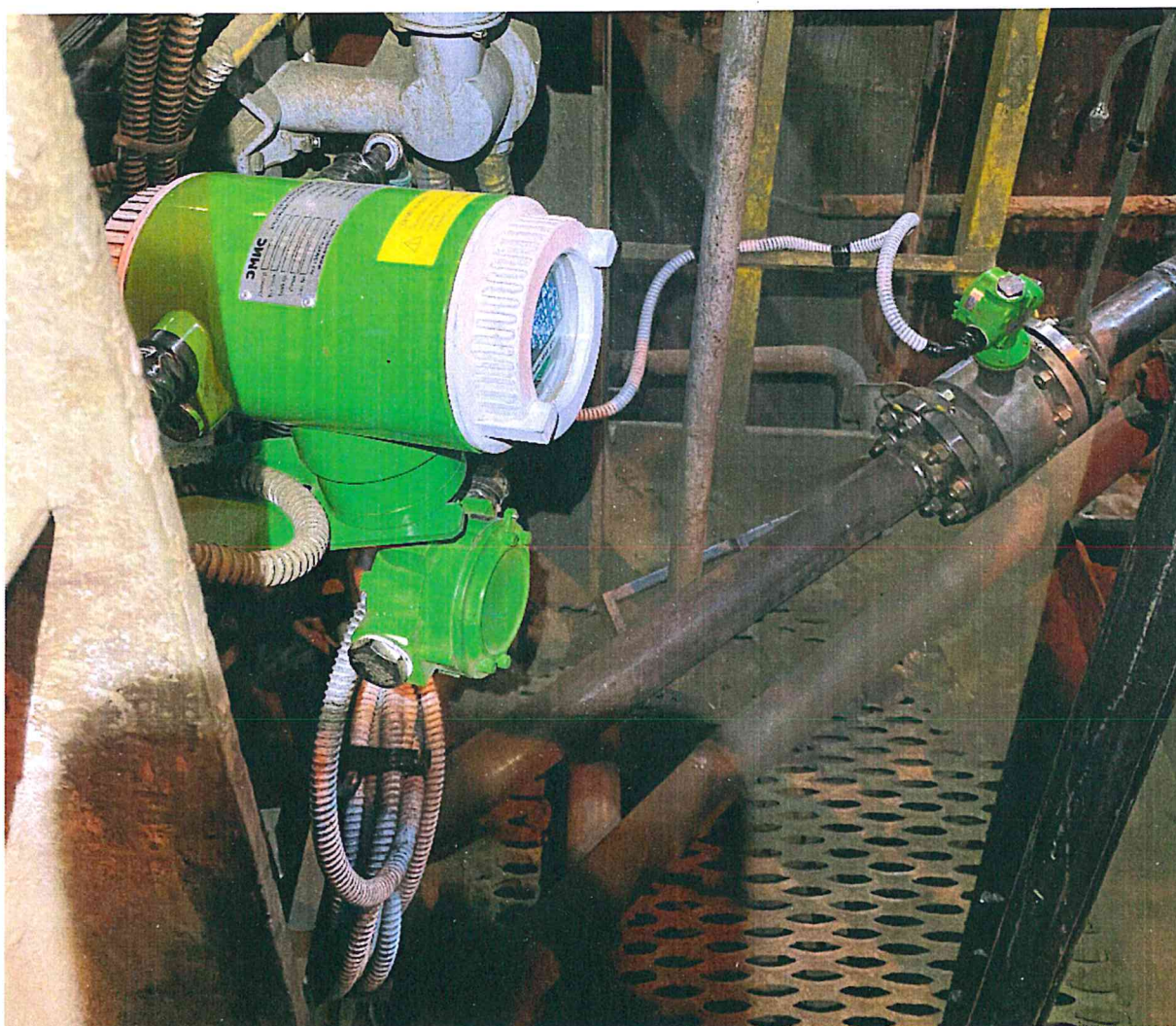
Рис. 10. Фото расходомера ЭМИС на позиции проведения ОПЭ
